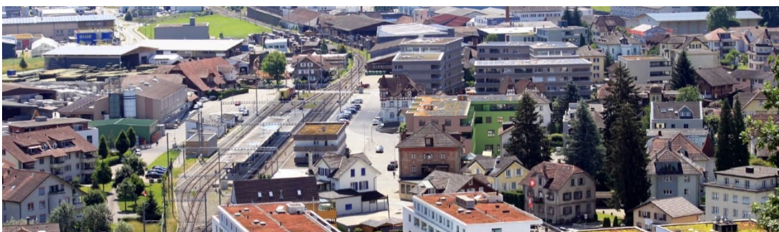
Abb. 4: Blick auf den Bahnhof
