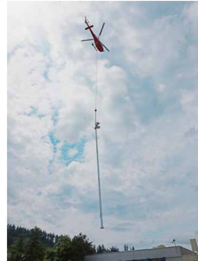
Am 20. Mai 2025 wurden die vier Kandelaber mittels Helikopter-Einsatz installiert – ein Spektakel, welches viele Zuschauer anlockte.
