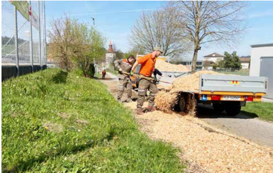
Bei der Finnenbahnsanierung durfte das Sportzentrum-Team auf die Unterstützung von Zivildienstleistenden zählen. Die 350 m lange Finnenbahn präsentiert sich nach den Unterhaltungsarbeiten wieder in bestem Zustand und lädt zur Benützung ein. Wir wünschen viel Spass und Laufvergnügen.
