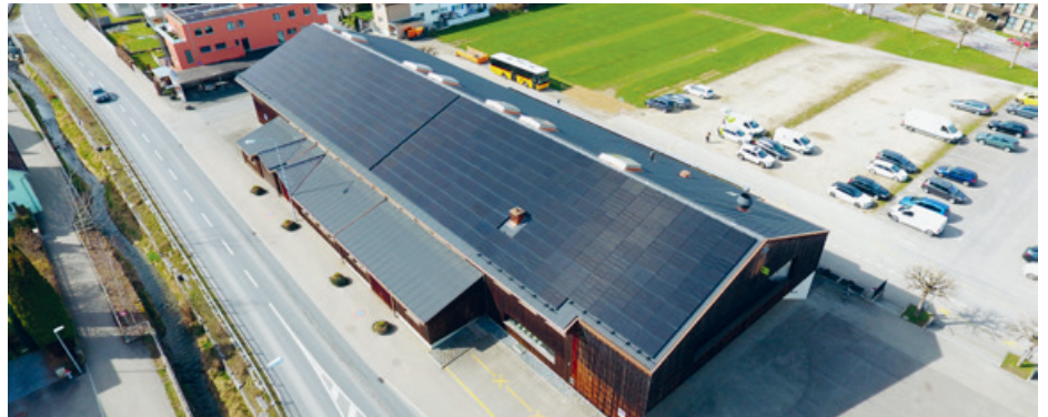
Abgeschlossene Sanierung Festhalle.
