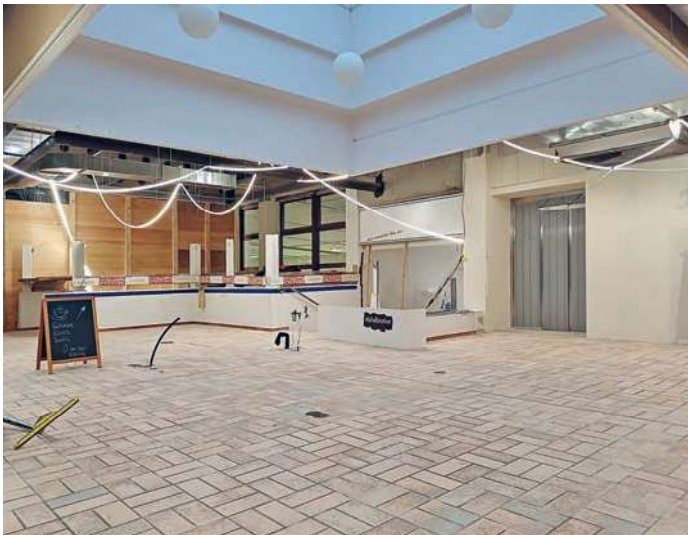
Umbauarbeiten Cafeteria im Dezember und Januar.
