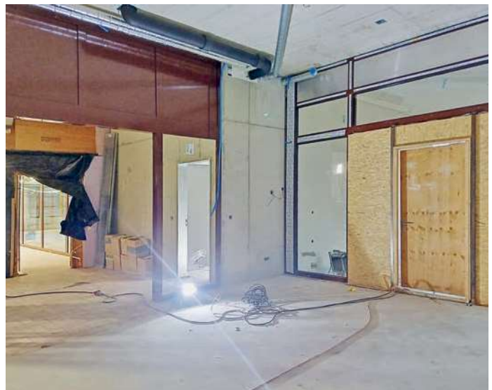
Der neue Eingangsbereich nimmt Formen an.
