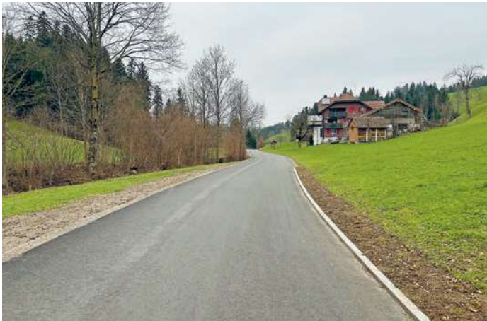
Die sanierte Rohrmattstrasse.
