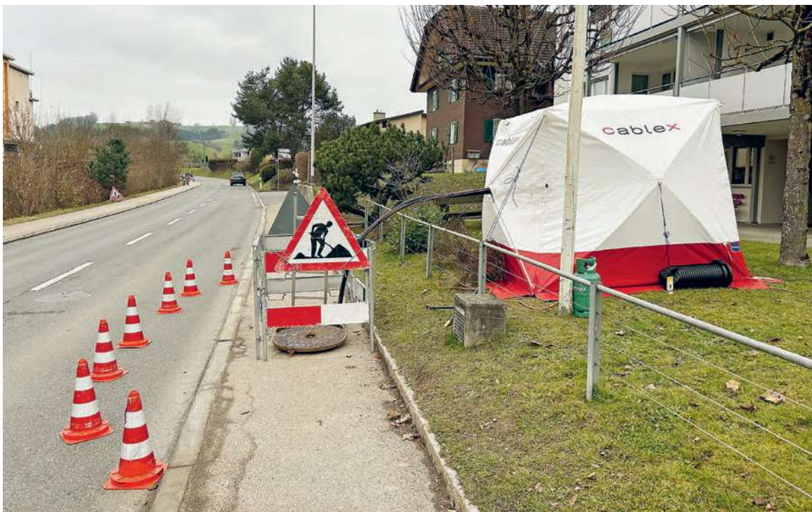
Die cablex AG zieht das Glasfaserkabel ein.
