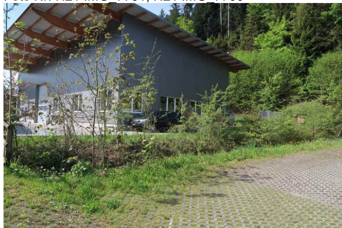
Foto Nr: H21 IMG 7701; H21 IMG 7700
