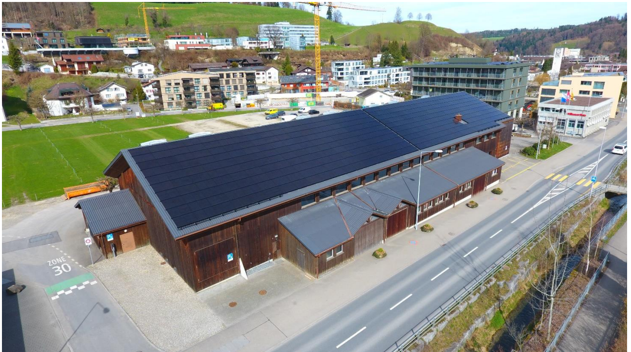
Bild: Photovoltaikanlage Festhalle
